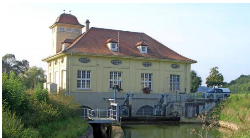
Malerisch an der Jagst gelegen, erzeugt das Wasserkraftwerk Duttenberg seit 1914 elektrische Energie. Foto: privat
