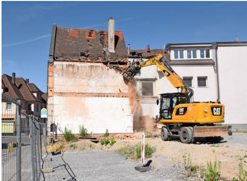
Der Abrissbagger leistet ganze Arbeit: Mit neuer Wohnbebauung, Gastronomie, einem Laden und Arztpraxen soll die Ortsmitte künftig belebt werden. Foto: privat
