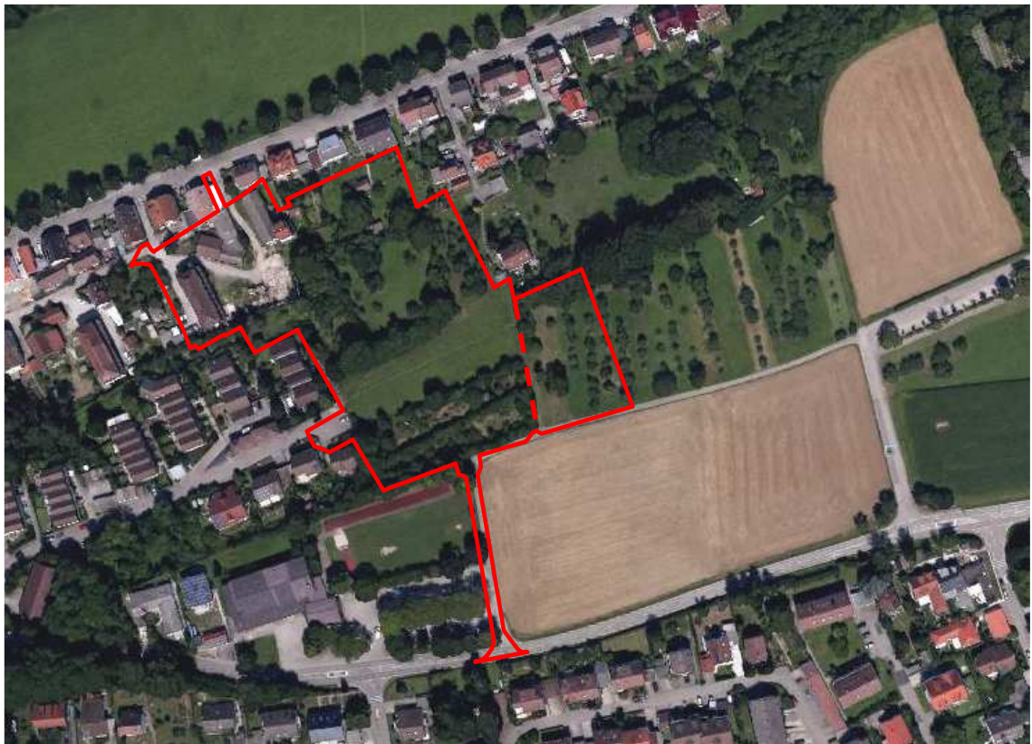
Abb. 2: Luftbild des erweiterten Plangebietes (Quelle: Google Earth)
