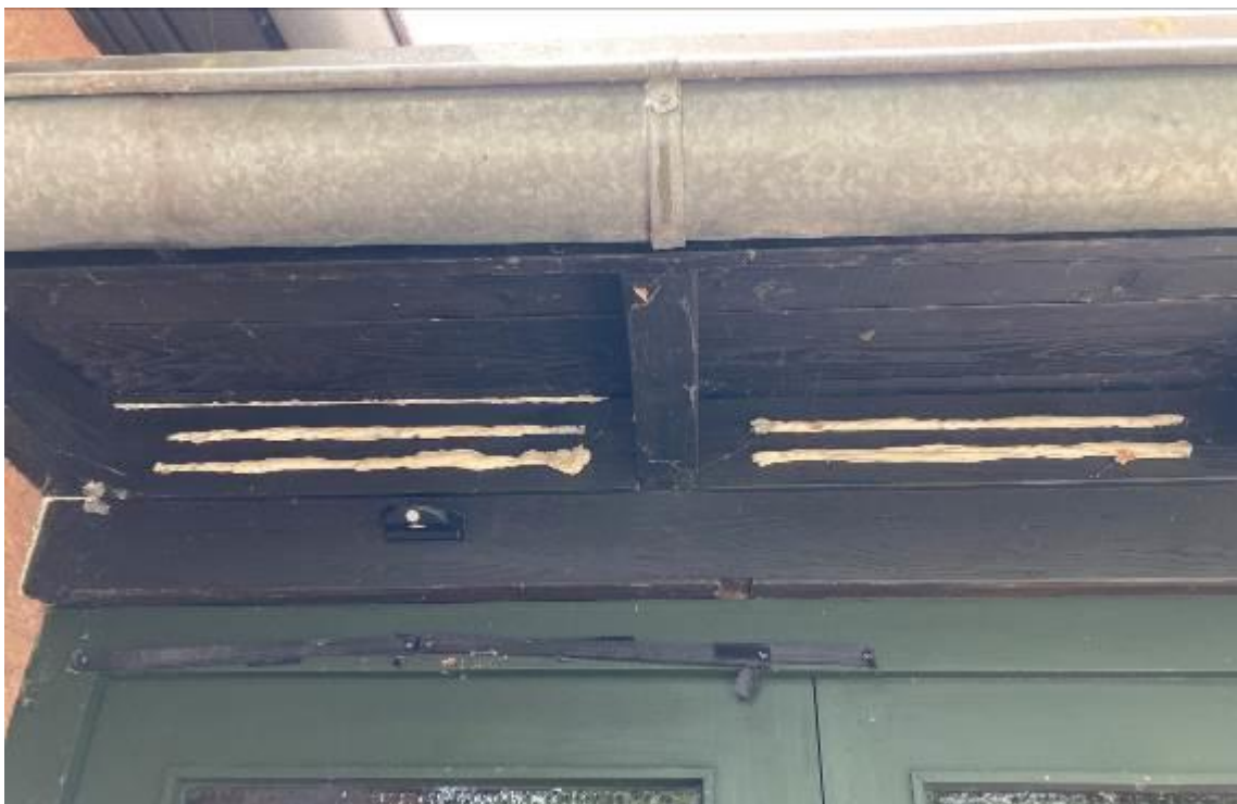
Abbildung 8: Potenzial für Fledermausquartiere an Außenfassade der Sporthalle
