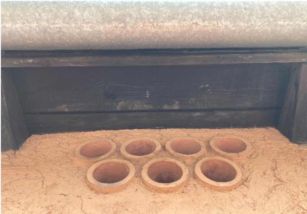
Abbildung 9: Potenzial für Fledermausquartiere an Außenfassade der Sporthalle
