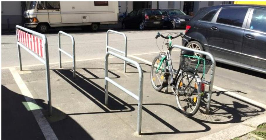
Abbildung 75: Fahrradanlehnbügel Typ „Rahmenhalter“ (eigene Darstellung, VAR+, 2021)
