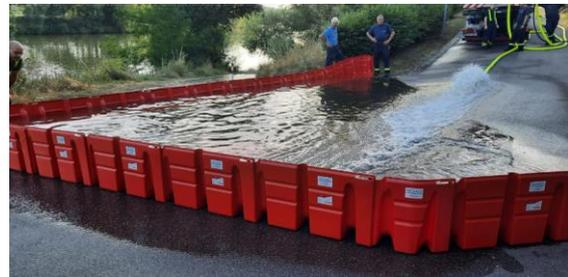
Um für Hochwasser- und Starkregenereignisse noch besser gerüstet zu sein, wurde von der Stadt für den Bevölkerungsschutz ein freistehender mobiler Hochwasserschutz beschafft. Speziell entwickelt für den Einsatz im städtischen Bereich, auf harten und ebenen Flächen wie Asphalt und Beton.
