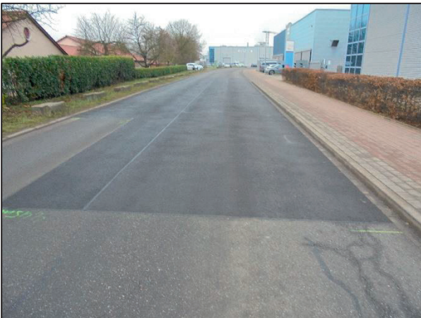
Neuer Asphaltbelag im Teilabschnitt Bergrat-Bilfinger-Straße
