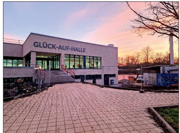
Neue Fassade und Bau der neuen Außenanlage Dezember 2025
