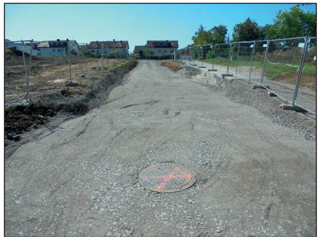
Baustraße zwischen Brauerei-Elsässer- und Neuenstadter Straße
