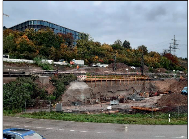
Baustelle für Bahnsteig und Brückenfundament
