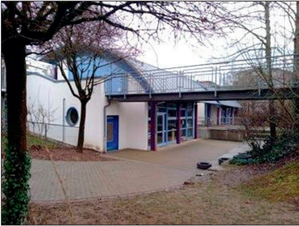
Kita Plattenwald – Fassade vor Sanierung Januar 2026
