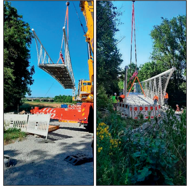
Montagearbeiten am Kochersteg
