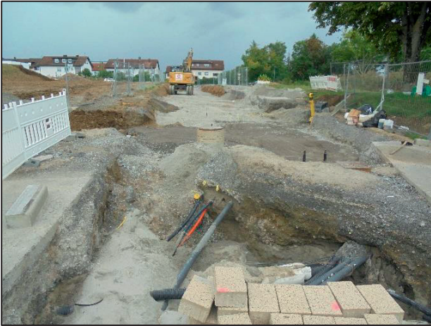
Tiefbauarbeiten am Lindenbergareal
