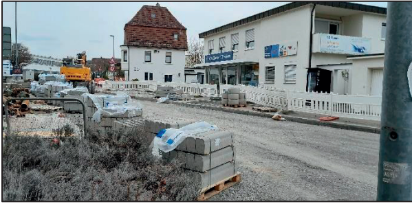
Vollausbau des Straßenkörpers
