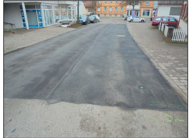
Hauptstraße nach dem neuen Deckeneinbau
