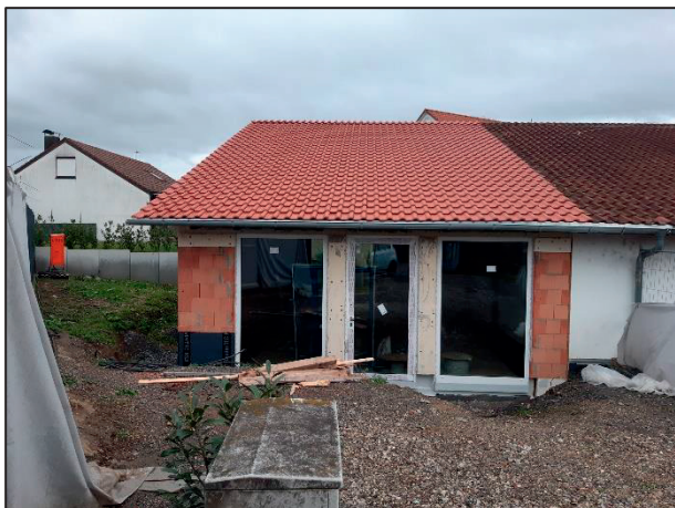
Grundschule Duttenberg, Erweiterung Mensa Bauzustand Dezember 2025
