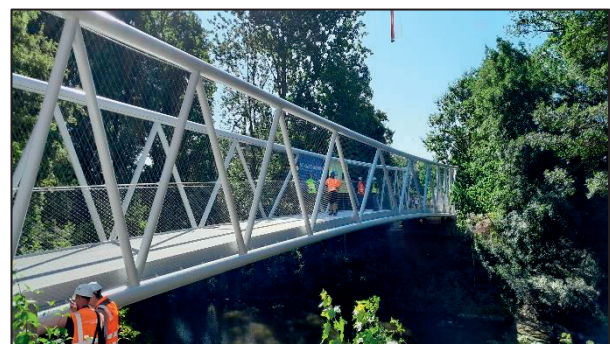
Neue Kochersteg - Brücke
