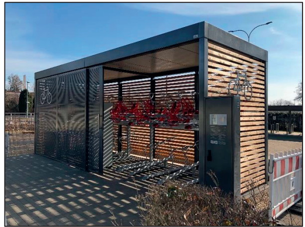
Sammelschließanlage Bahnhof Kochendorf
