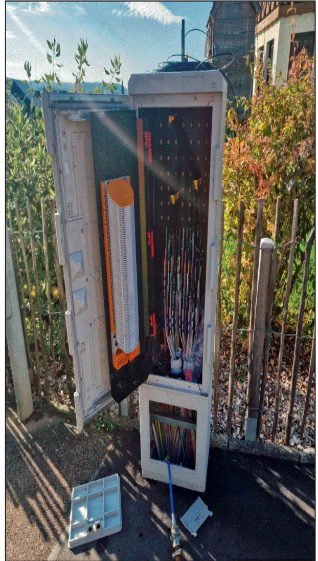
Netzverteilerpunkt NVT
