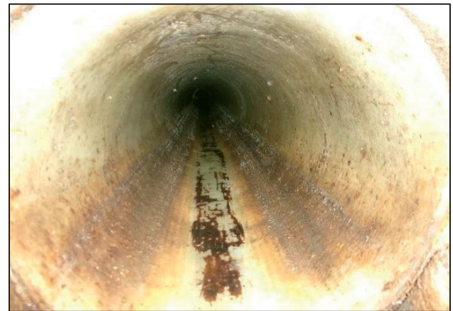
Inliner in Kanalhaltung
