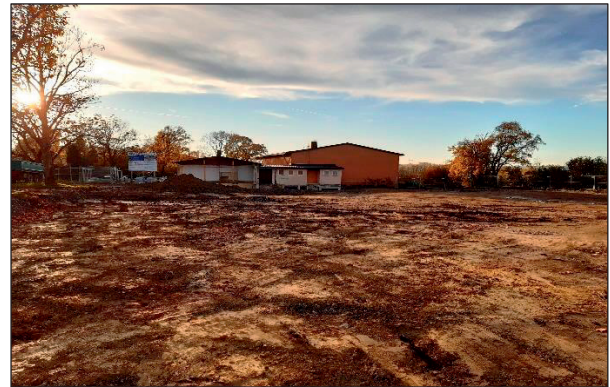
Neubau Lindenberghalle – Baustelle, Erdarbeiten November 2025
