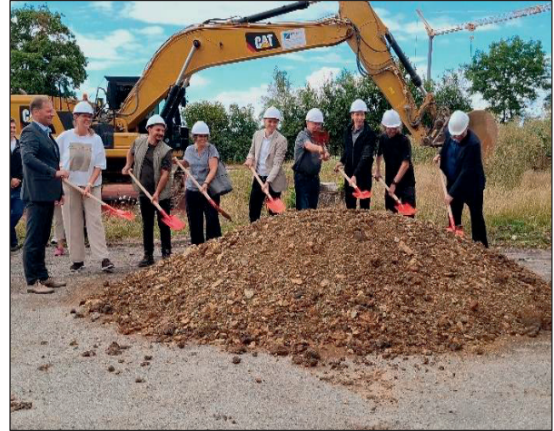
Neubau Lindenberghalle - Spatenstich Juli 2025
