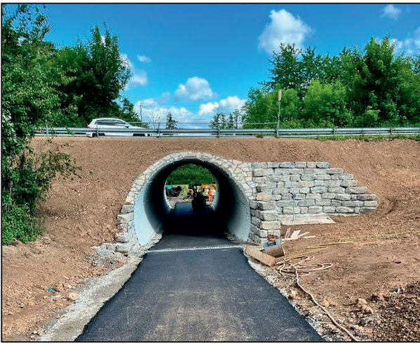
Erneuerung BW 5 nach Fertigstellung
