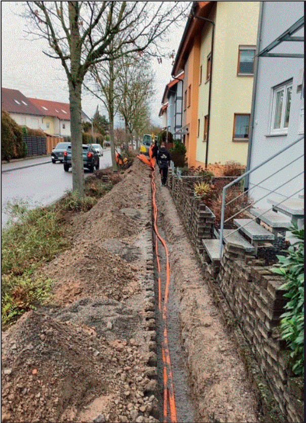
Verlegung der Verbände
