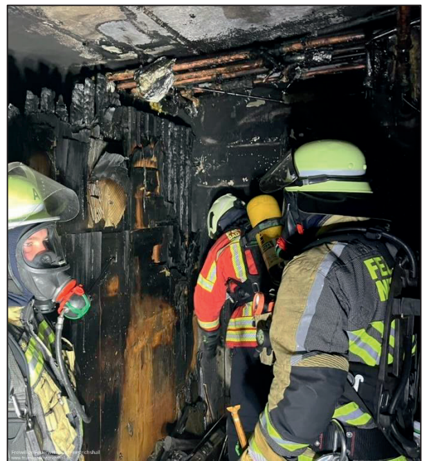
Einsatzstelle im Kellergeschoss
