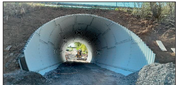
Einzug der neuen Wellstahlröhre
