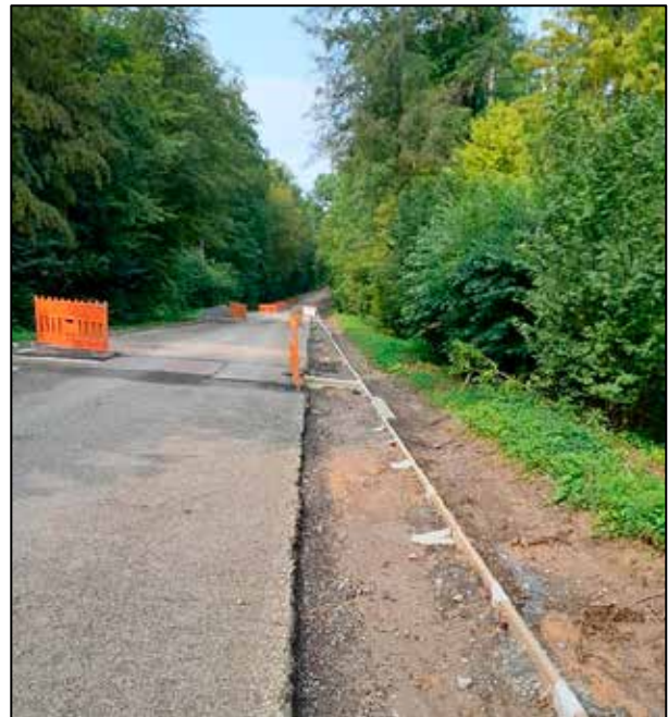
Einbau der Leiteinrichtung
