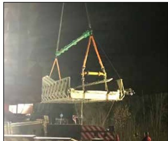
Das Ausheben der alten Brücke Bild M.M.
