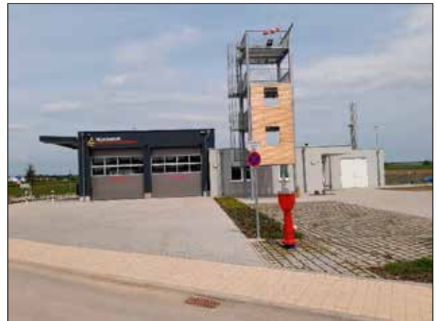
Ausrückwache mit Übungsturm und BHKW Stand Oktober 2023
