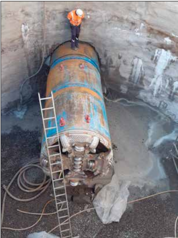
Bohrkopf hat Zielgrube erreicht
