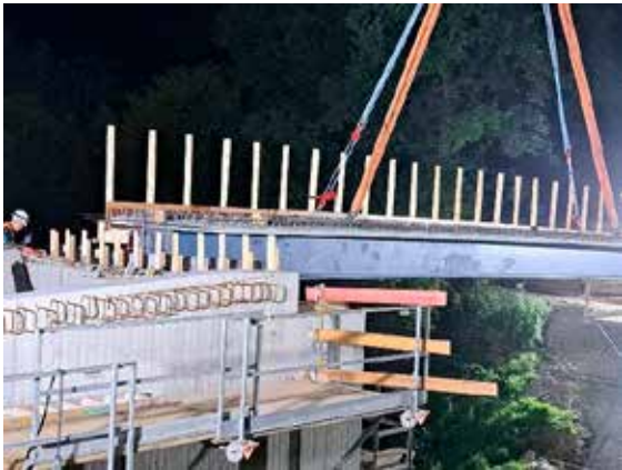
Das erste neue Brückenteil wird eingehoben. Bild M.M.
