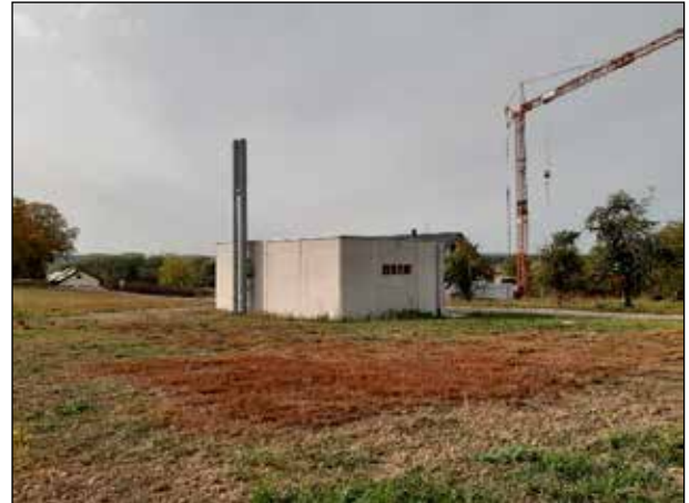
BHKW Neuenstädter Straße: Fertiggestellter Rohbau Oktober 2023
