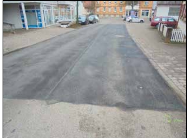
Hauptstraße nach dem neuen Deckeneinbau
