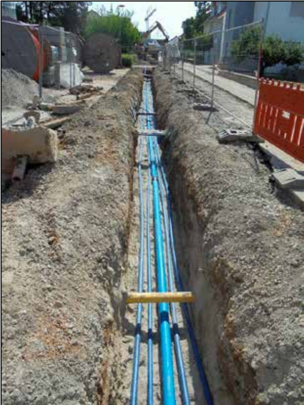
Wasserleitungsgraben in der „Lange Straße“
