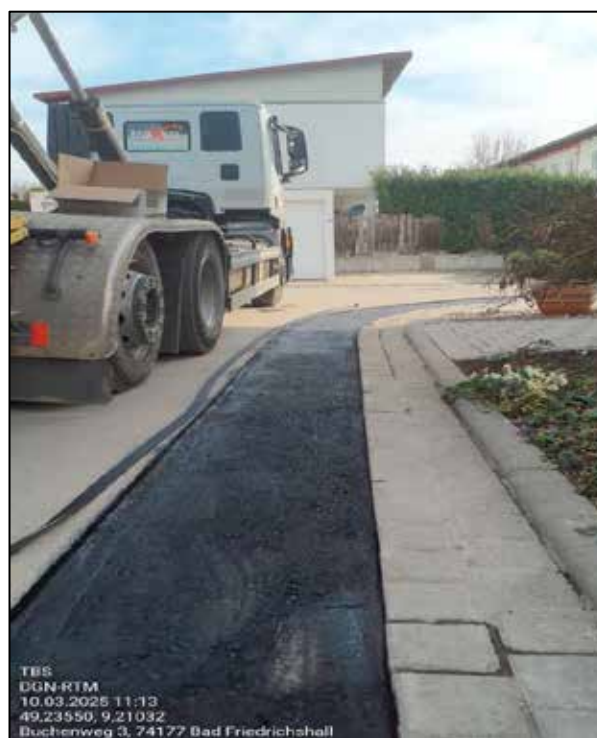
Asphalttragschicht eingebaut
