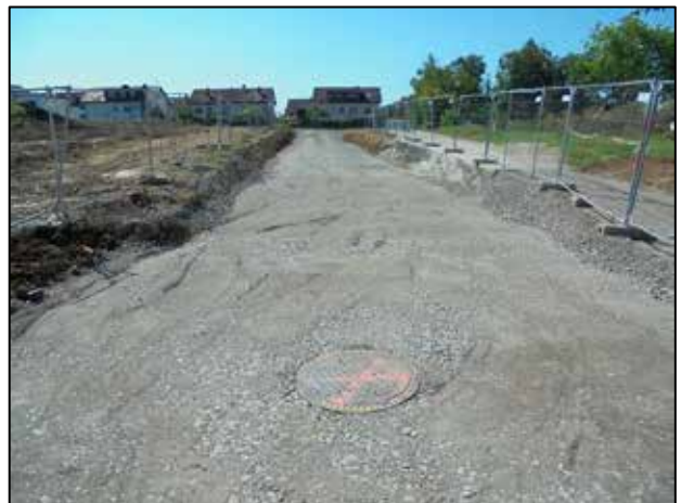
Baustraße zwischen Brauerei-Elsässer- und Neuenstadter Straße
