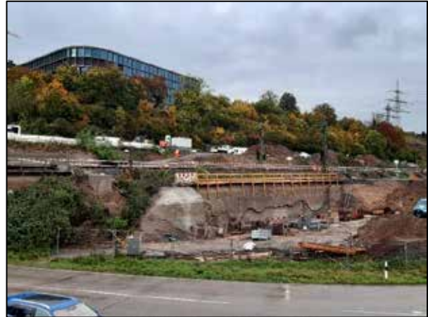
Baustelle für Bahnsteig und Brückenfundament
