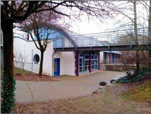
Kita Plattenwald – Fassade vor Sanierung Januar 2026
