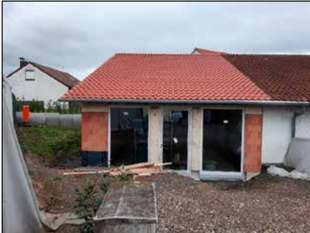
Grundschule Duttenberg, Erweiterung Mensa Bauzustand Dezember 2025
