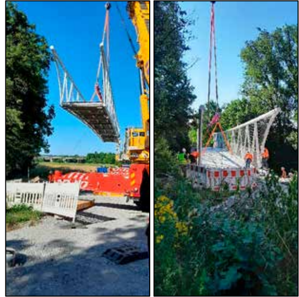
Montagearbeiten am Kochersteg
