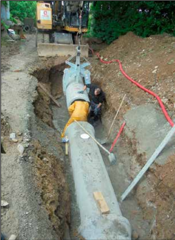
Kanalgraben in der Mühlstraße
