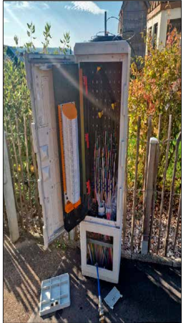
Netzverteilerpunkt NVT
