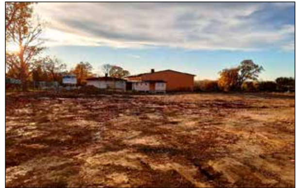
Neubau Lindenberghalle – Baustelle, Erdarbeiten November 2025
