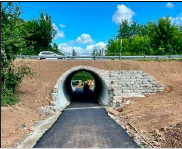
Erneuerung BW 5 nach Fertigstellung
