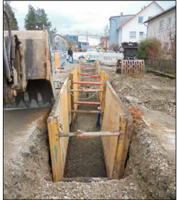
Kanalgraben in der „Lange Straße“
