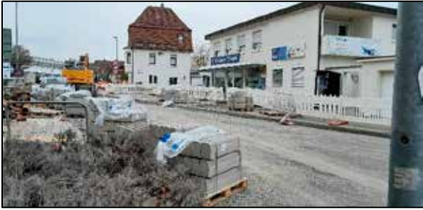
Vollausbau des Straßenkörpers
