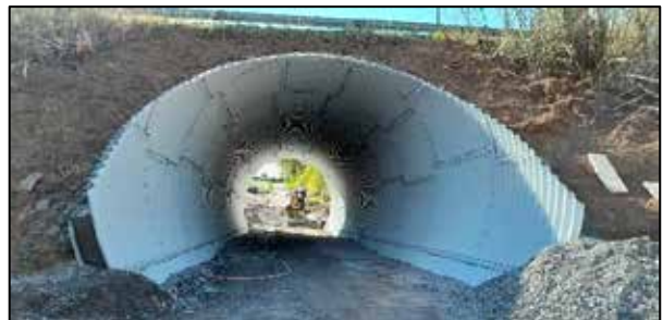
Einzug der neuen Wellstahlröhre
