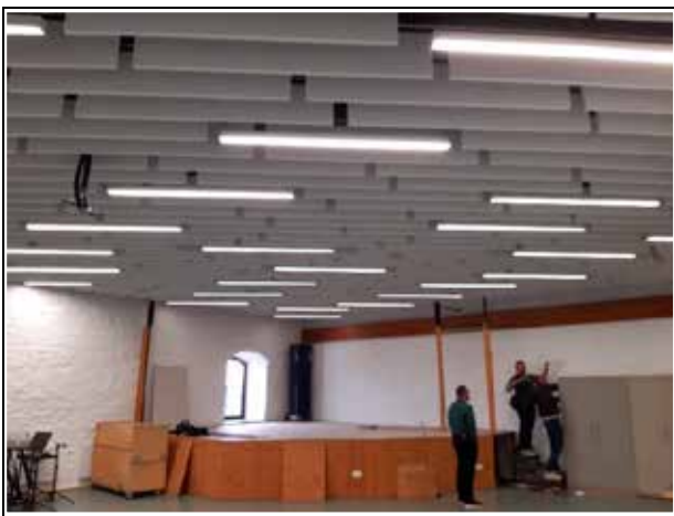
Alte Kelter Duttenberg – neue Decke im Keltersaal Mai 2025
