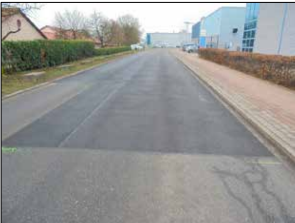
Neuer Asphaltbelag im Teilabschnitt Bergrat-Bilfinger-Straße
