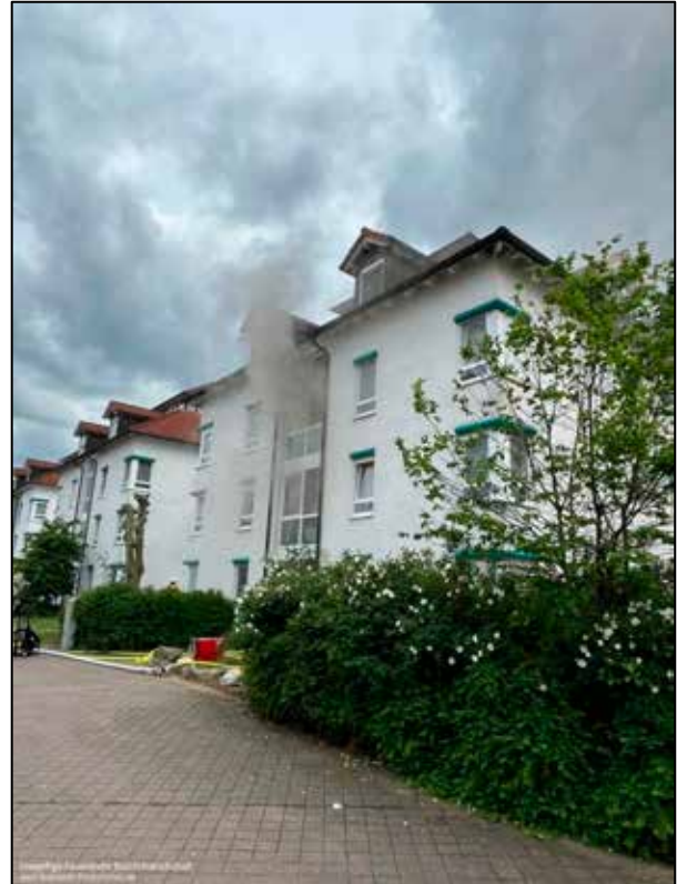
Rauchentwicklung aus dem Gebäude
