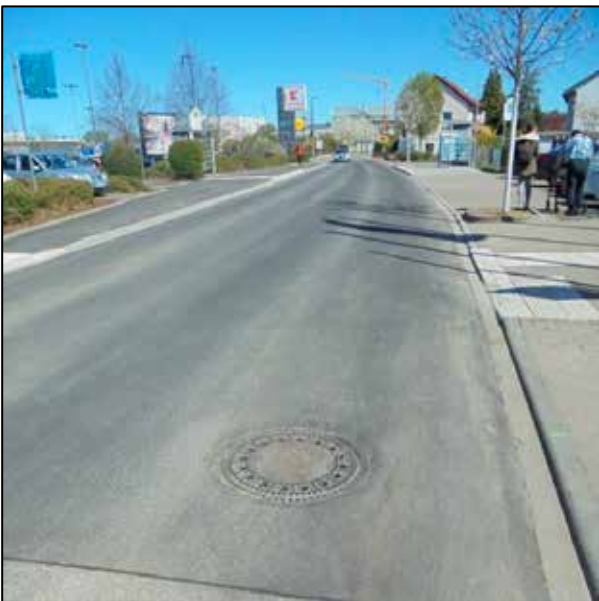
Neuer Asphaltbelag bei der Bushaltestelle in der Industriestraße
