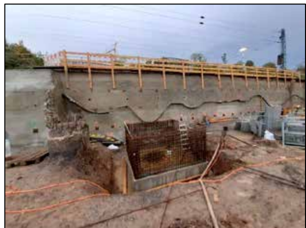
Stützenfundament Achse
