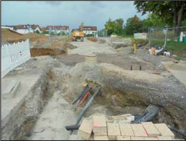
Tiefbauarbeiten am Lindenbergareal
