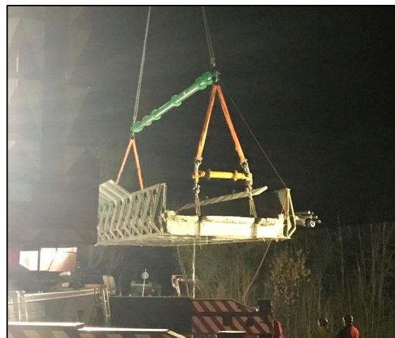
Das Ausheben der alten Brücke Bild M.M.
