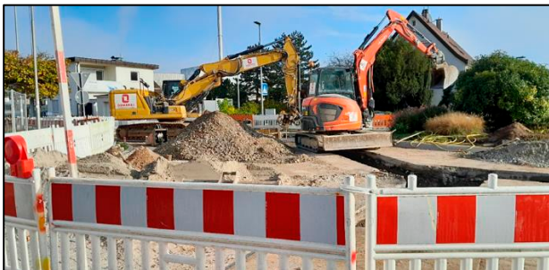
Baubeginn am Kreisel „Industriestraße“
