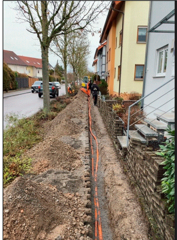
Öffnung des Kanals und Verlegung der Verbände
