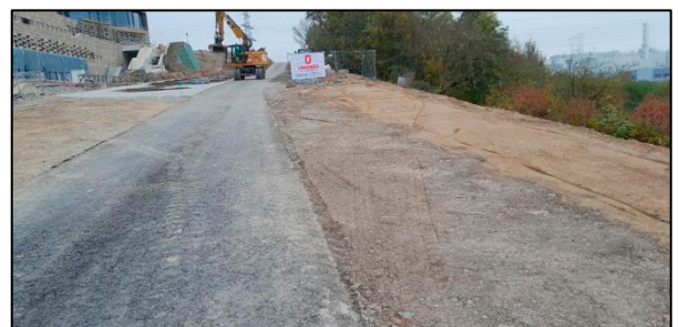
Ausbau Wirtschaftsweg BG „25/8 Obere Fundel“ zum Geh- und Radweg
