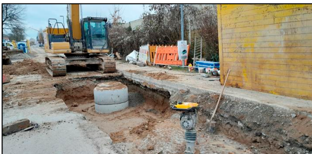
Erneuerung Schachtbauwerk Kocherwaldstraße
