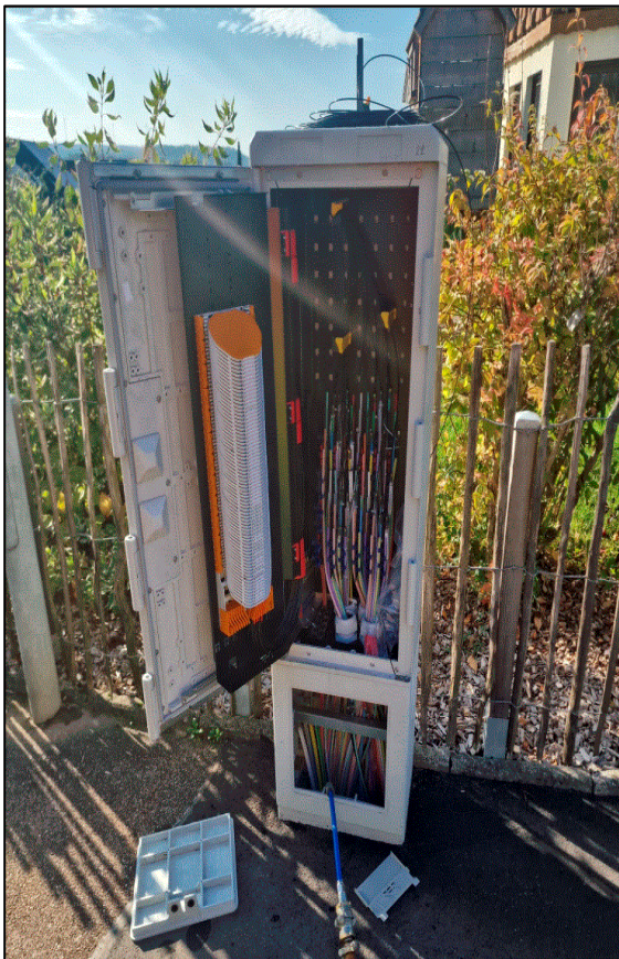
Netzverteilerpunkt NVT
