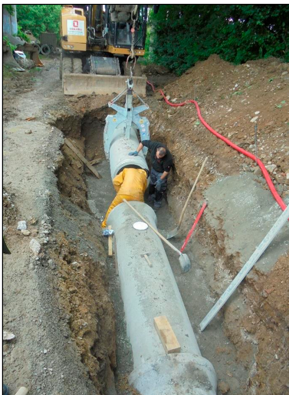
Kanalgraben in der Mühlstraße
