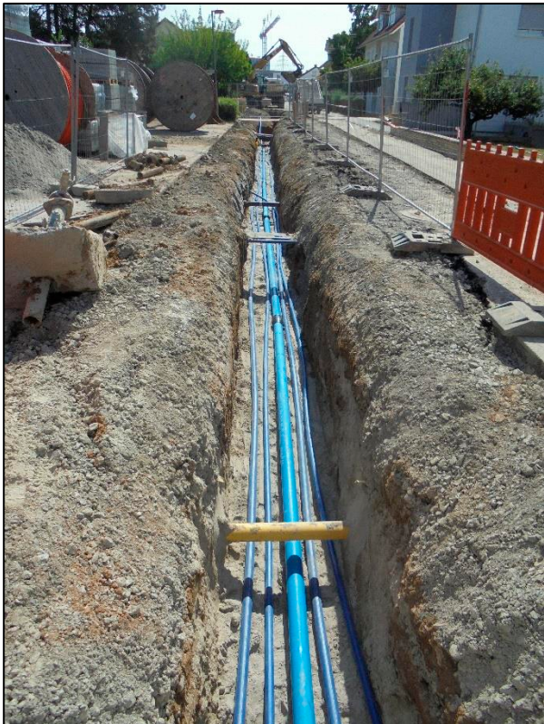
Wasserleitungsgraben in der „Lange Straße“
