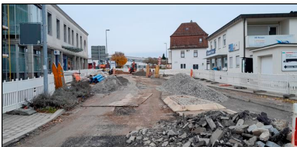
Leitungsbau in der Kocherwaldstraße
