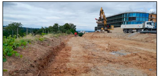
Erdarbeiten am Geh- und Radweg
