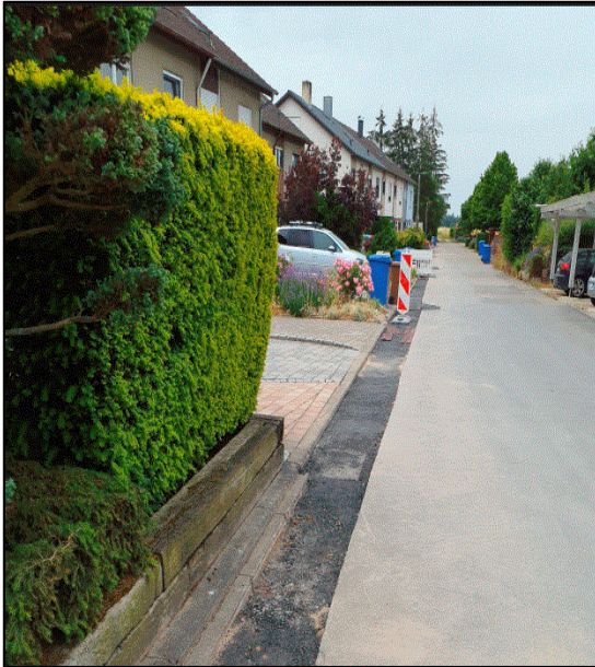
Strecke des Kanals, Asphalt Tragschicht einbauen
