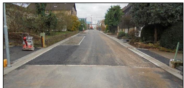
„Lange Straße“ nach bituminösem Tragschichteinbau
