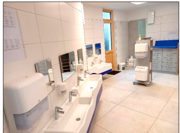
Anbau KiTa Dresdner Straße – WC-Anlage für die Kinder Dezember 2023
