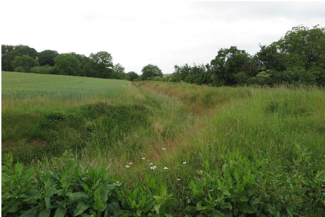
Bild 15: Das Plangebiet wird bereits durch aufwändig geschaffene Flutmulden eingegrenzt. Diese sollen mögliche Oberflächenwasser, aufgrund der stark abfallenden Ackerflächen, erfassen und ableiten.
