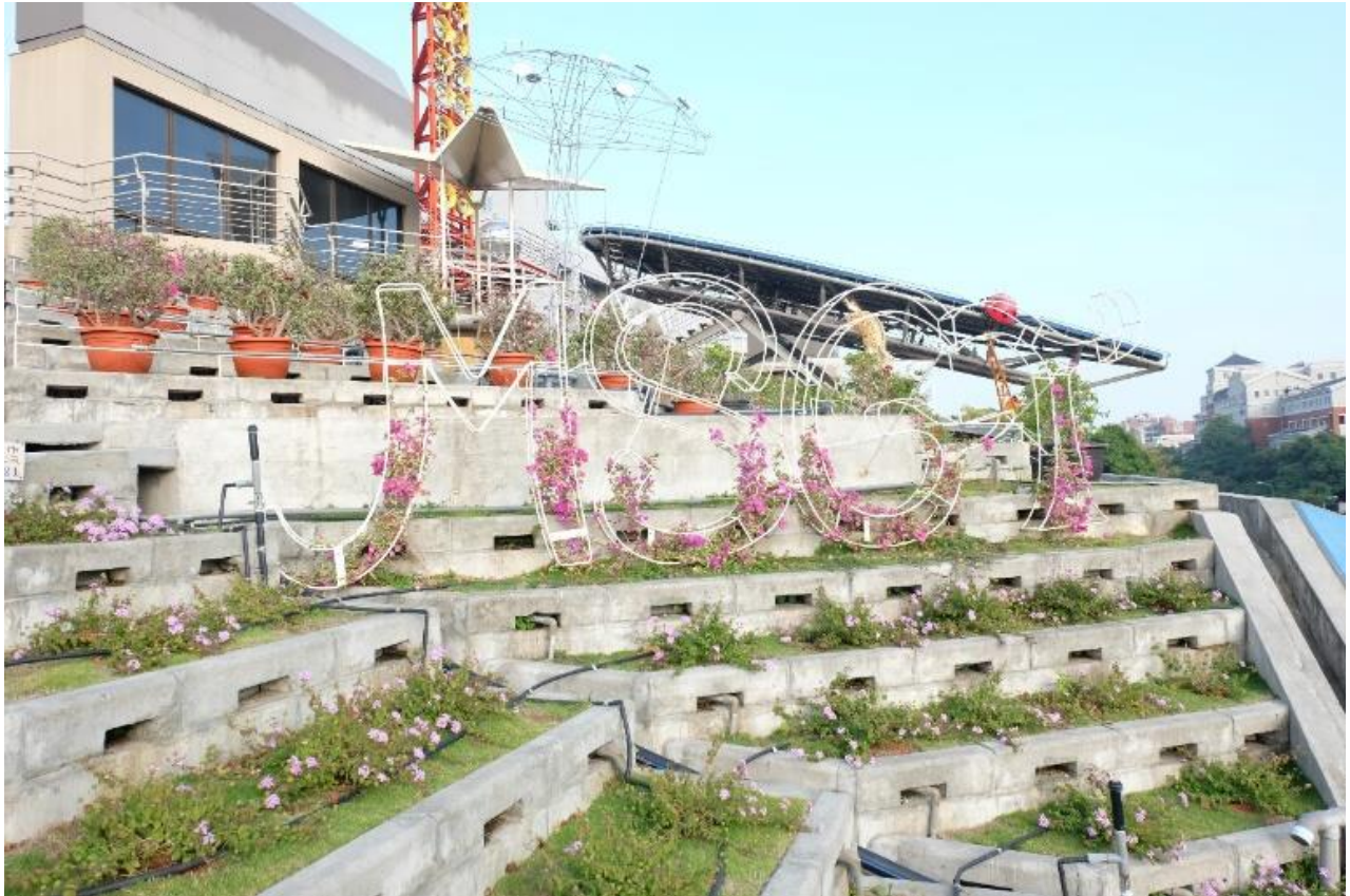
Abbildung A2-5: Kombination von intensiver Dachbegrünung, Photovoltaikanlage und Windkraft-Tower auf einem Dach der Universität in Tainan, Taiwan.
