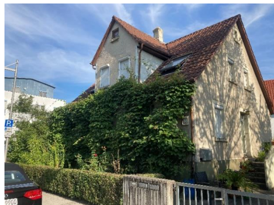
Abb. 6: Südliches Wohnhaus im Sommer
